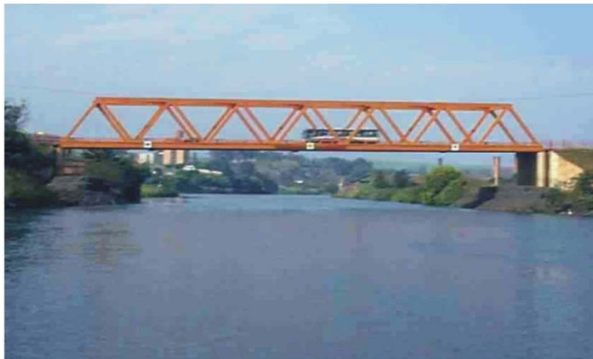
Ponte Igarçu do Tietê / Barra Bonita
