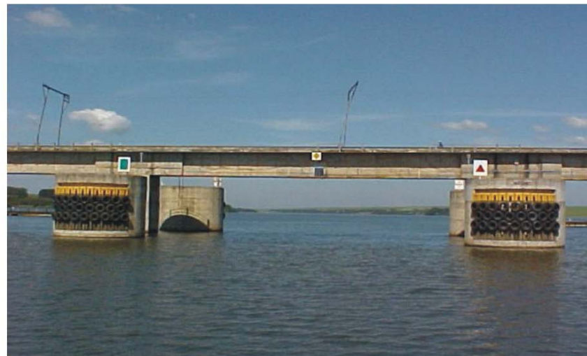
Dolphins de proteção em concreto
