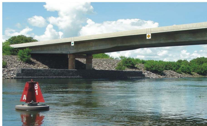
Proteção em gabião
